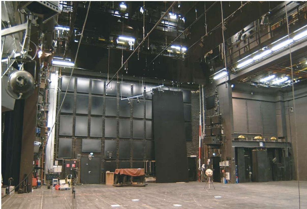
Gezählter Raum. Tieffrequente Absorber im Bühnenturm des Staatstheaters Mainz sorgen für eine gleichmäßige Akustik unabhängig vom Bühnenaufbau.
